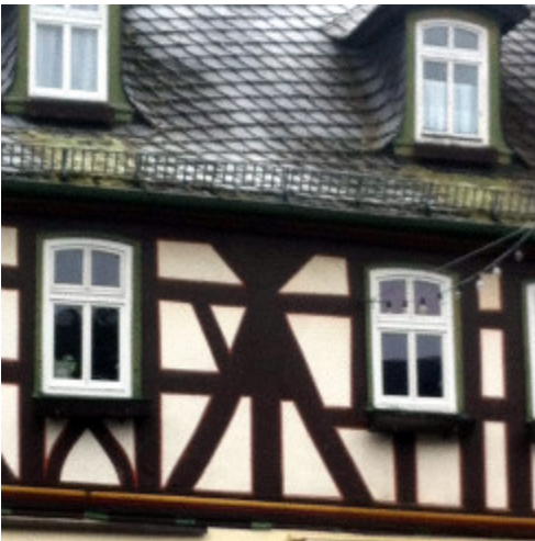
Bild [2]: Der „ Hessenmann “: Dieser hatte eine unheilabwehrende Funktion im Mittelalter. Die Form entwickelt sich durch die Verstrebung von Kopfwinkelhölzern mit verkürzten Kopfstreben und dreiviertel-geschosshohen Fußstreben. [+]
